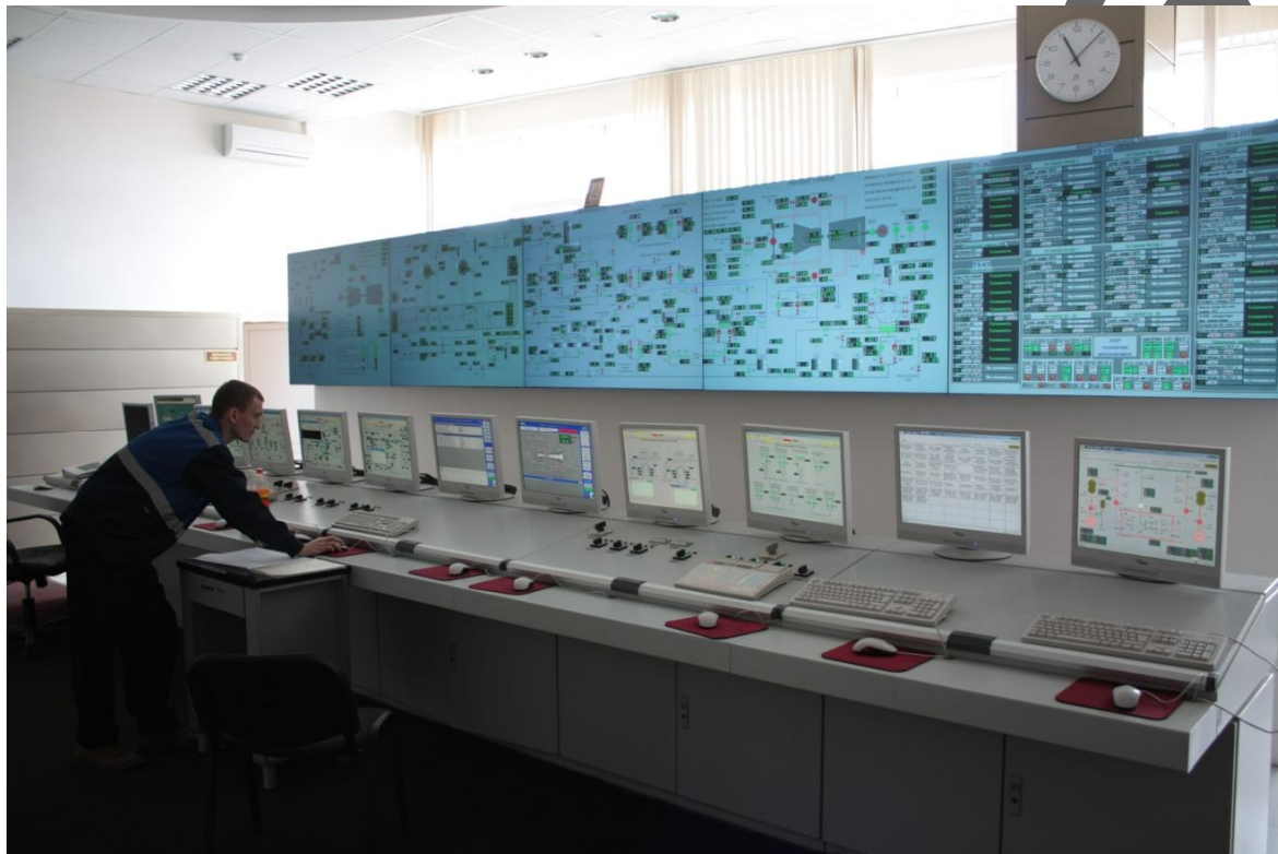
Рисунок 2.49 – Вид блочного щита ПГУ-230
